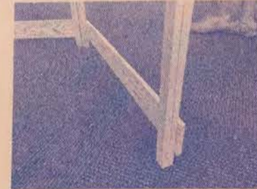
水杭・水貫・水糸で構成される
